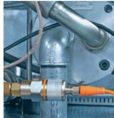
Les boîtiers inox des transmetteurs PA et PT permettent une solution compacte et robuste.
