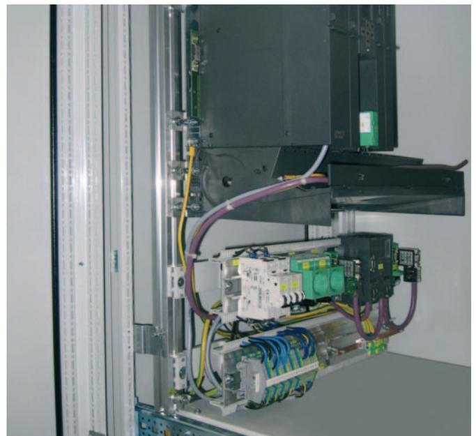
Système LSC-BRACKET dans une armoire de programmation
