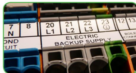
Facilité de repérage des bornes et des groupes de bornes sur la même étiquette.
